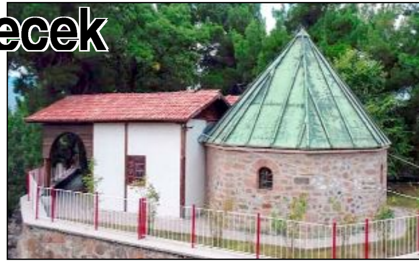
İkinci Beyazıt tarafından yaptırılan tarihi türbenin restorasyon çalışmaları kısa süre içinde başlayacak.
