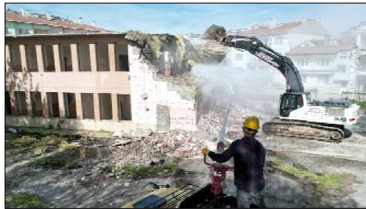
Metruk halde bulunan eski kız İmam Hatip Lisesi'nin yıkımı Çorum Belediyesi ekiplerince yapıldı.
