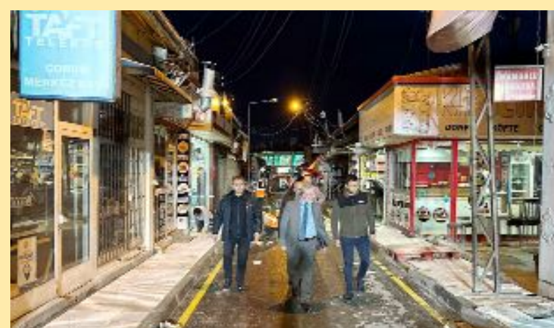
Çorum Belediyesi, Çöplü Arastası Hamit Cami Sokak'ta gece saatlerinde kaldırım çalışmalarını tamamladı.
