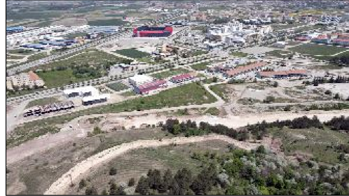
Yeni diş hastanesi ile Sanayi Sitesi ve Mimarınan Mahallesi'nin bağlantısını sağlayacak Mimarınan 9. Cadde'de yol açma çalışmaları devam ediyor.
