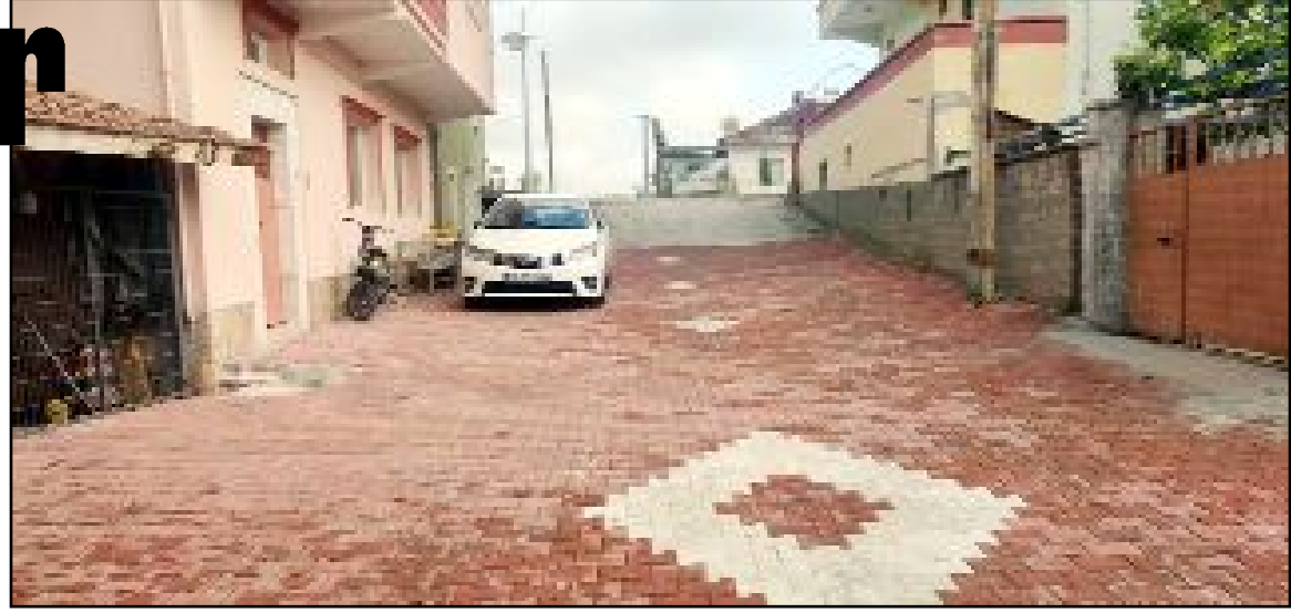
İlçedeki bozulan kilittaşlarının yenilenmesi çalışması kısa sürede bitirilecek.
