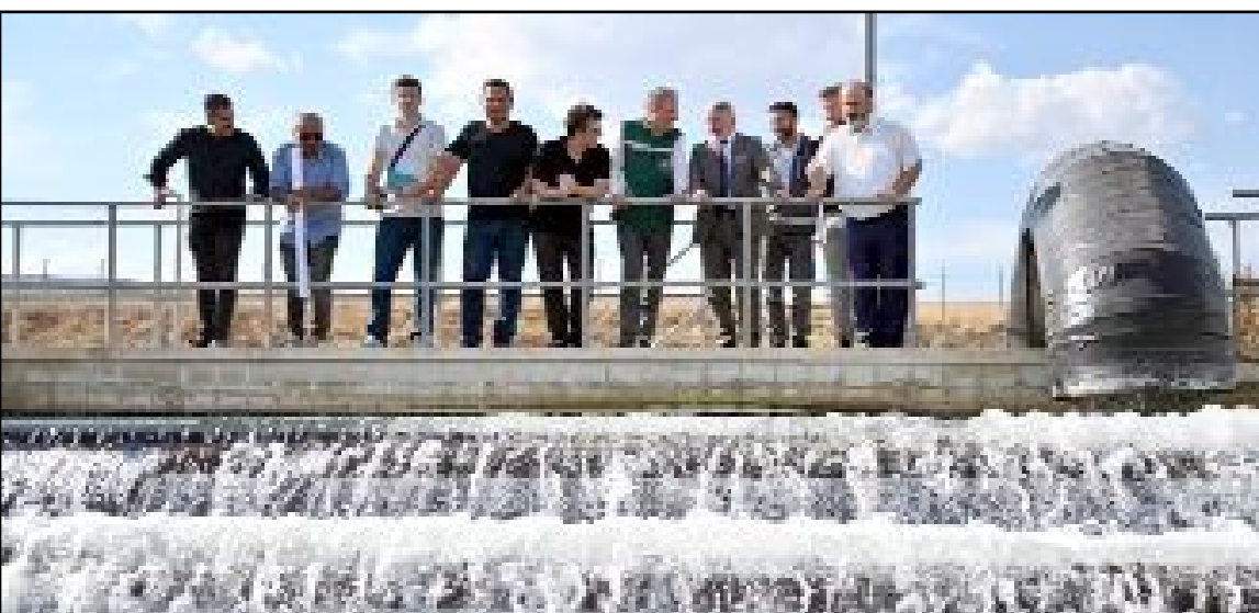
Başkan Aşgın ve firma yetkilileri mevcut arıtma tesisini incelerken, yeni tesisin 24 ayda bitirileceği açıklandı.
