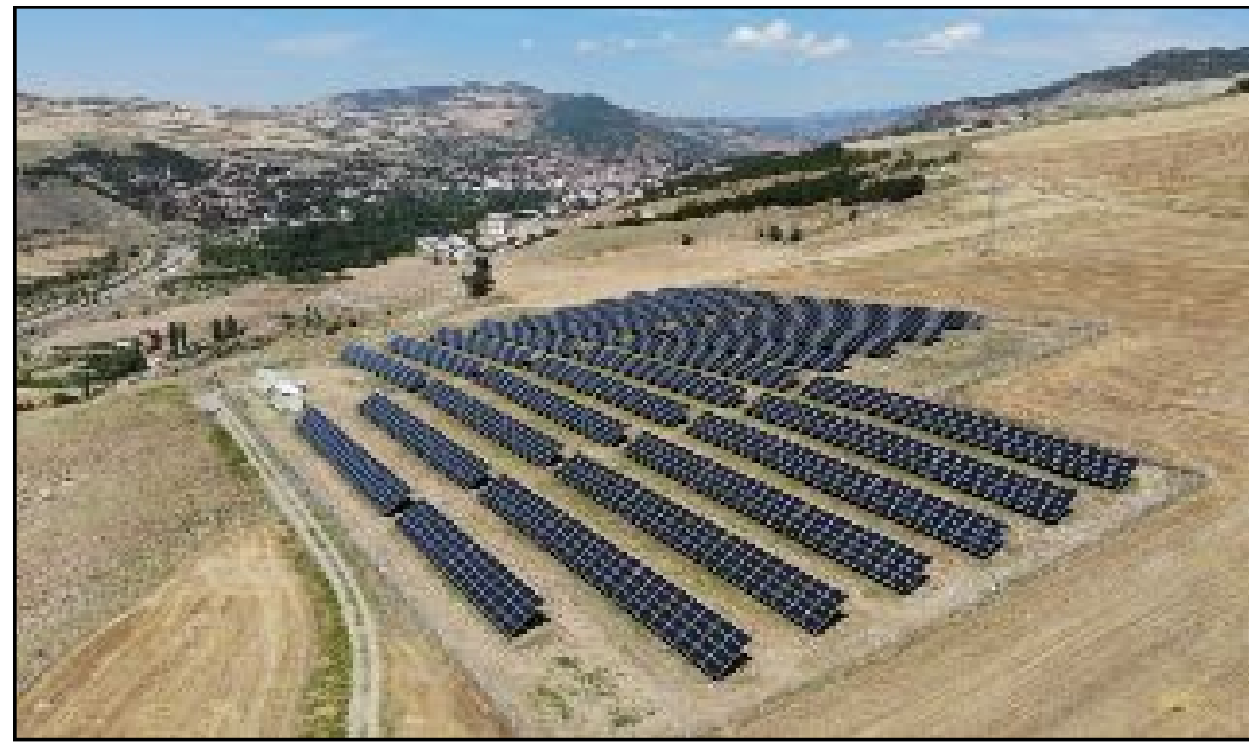
Bayat Belediyesi kurduğu güneş enerjisi santraliyle kendi enerjisini üretiyor.
