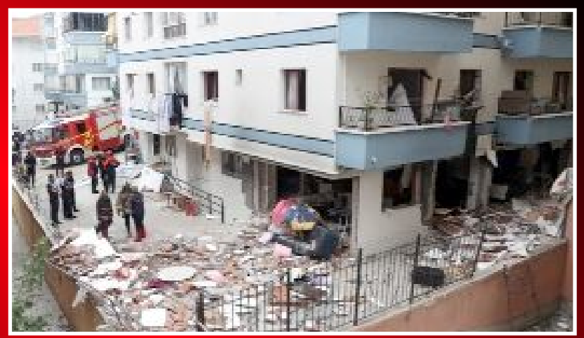
Doğalgaz patlaması dün Mamak Küçük Kayaş Mahallesi'nde bir evde meydana geldi.
