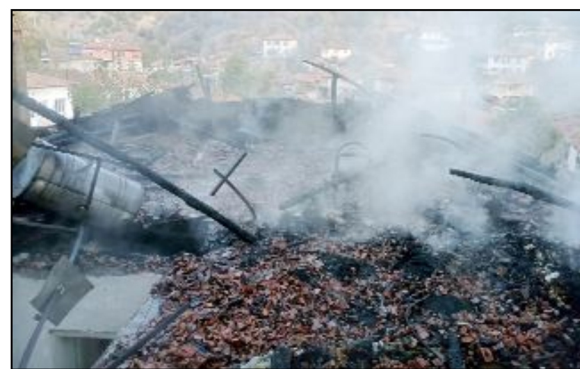
Dodurga Obruk Köyü'ndeki yangında ev kullanılmaz hale geldi.
