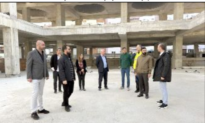
Bedesten ve yer altı otoparkı ikmal inşaatı işinin ihalesini kazanan yüklenici firmaya yer teslimi yapıldı.
