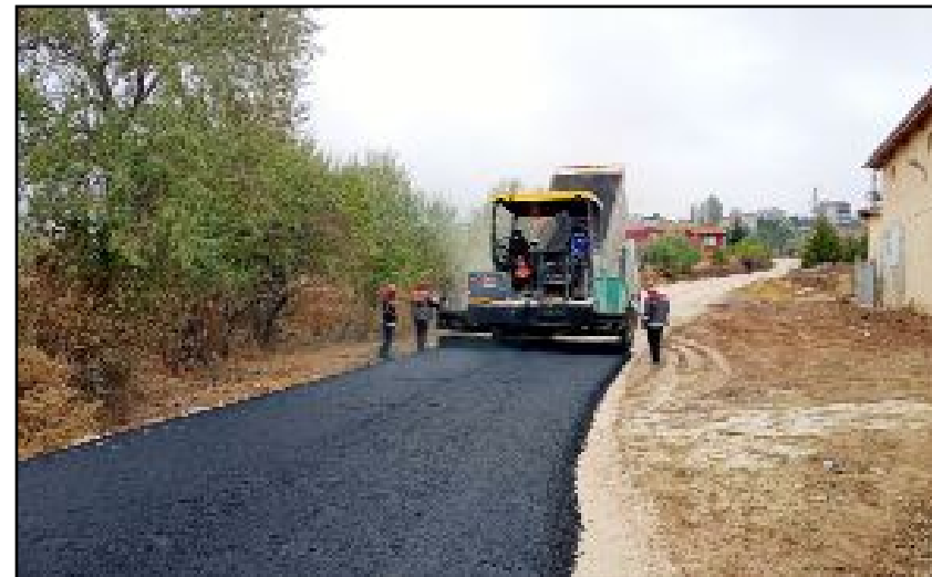
Çorum Belediyesi tarafından Ortaköy'de 1400 metre yolda asfalt çalışması yapıldı.
