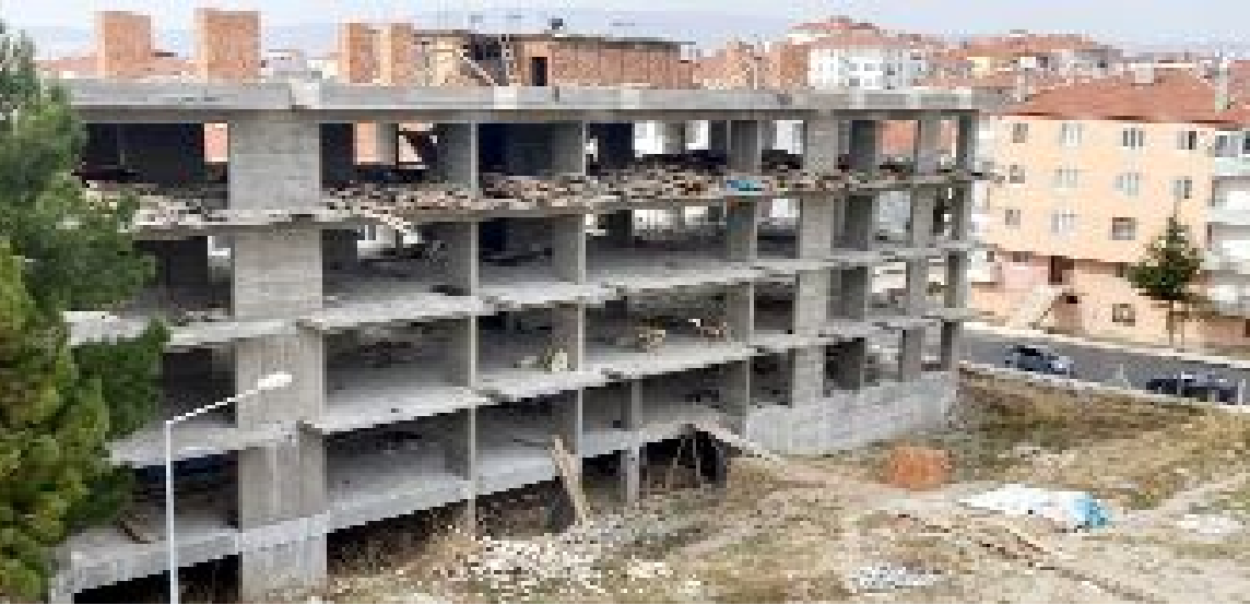
"Rıza Şehri" de denilen sosyal tesisler inşaatının son halii...
