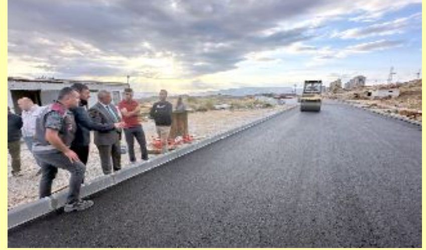
Çorum Belediyesi Cumartesi günü yapılacak belirtilen asfalt serimini yağış nedeniyle önceki gün yapmaya başladı. Çalışmaları Belediye Başkanı Halil İbrahim Aşgın da takip etti.
