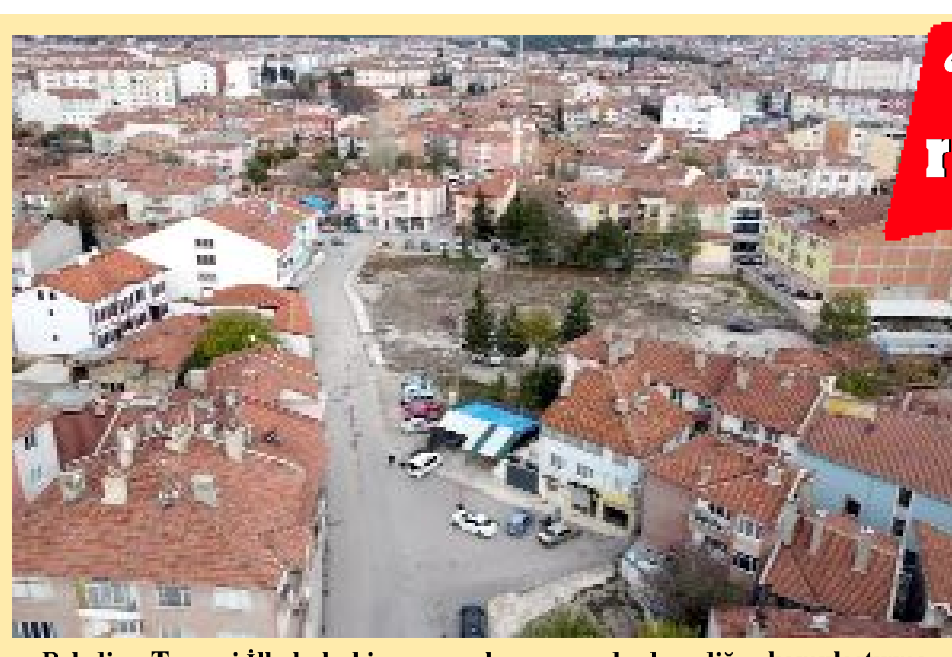
Belediye, Tanyeri İlkokulu binasının yıkımının ardından, diğer kamulaştırma işlemlerinin de tamamlanması ile birlikte yol genişletme çalışmalarına başlayacak.
