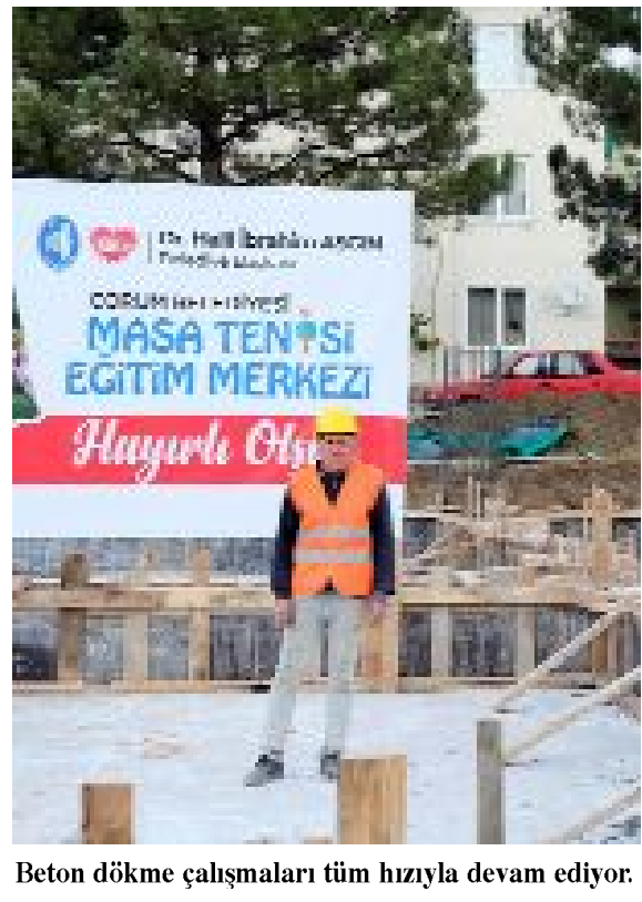
Beton dökme çalışmaları tüm hızıyla devam ediyor.
