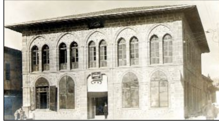
Yaklaşık 60 yıl belediye binası olarak kullanılan tarihi binanın, Çorum Belediyesinin geçen yılın sonunda yeni hizmet binasına taşınmasıyla aslına uygun şekilde kullanılması için çalışma başlatıldı.
