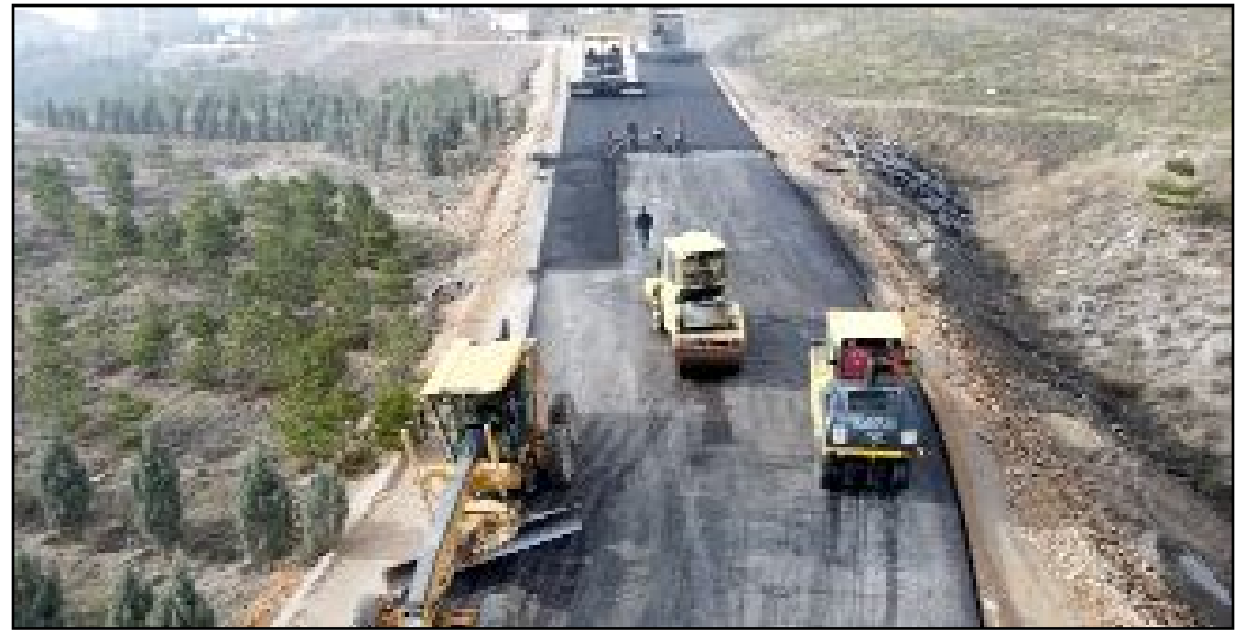
Belediye'ye bağlı asfalt ekipleri 450 metrelik yeni yolda asfalt çalışmalarını tamamladı.
