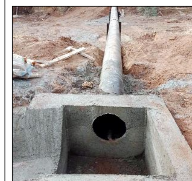
Eskialibey köyünde Yerüstü Sulama Tesisi tamamlanarak hizmete açıldı.
