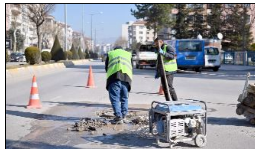
Eşref Hoca Caddesi'nde hummalı bir çalışma yürüten ekipler, rögar kapakları ile asfalt zemin arasında oluşan kot farkını sifıra indiriyor.
