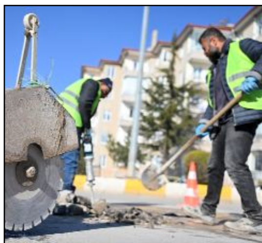
Eşref Hoca Caddesi'nde hummalı bir çalışma yürüten ekipler, rögar kapakları ile asfalt zemin arasında oluşan kot farkını sifıra indiriyor.
