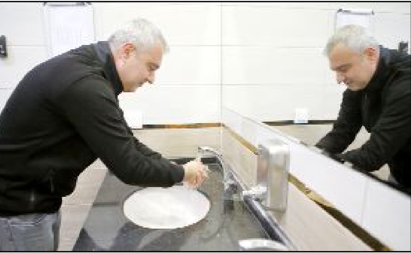
“Gri Su Tek” ile lavabo ve banyoda kullanılan atık su, filtre ve mor ışık teknolojisiyle yararlanarak tuvalet temizliğinde kullanılabilir hale getiriliyor.
