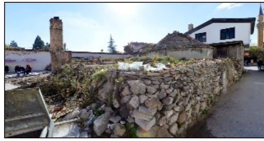
Aşgın, Tarihi Şehir Meydanı'nın kayıp mirası olan Güpür Hamamı'nı restore ederek şehir yaşamına kazandırmak için çalışmalarına hız vereceklerini bildirdi.
