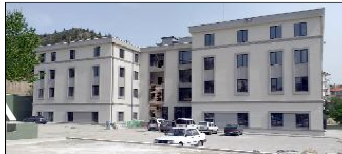
Binanın ikmal inşaatı için 24 Mayıs'ta yer tesliminin yapılmasının ardından yüklenici firmanın çalışmaları sürüyor.
