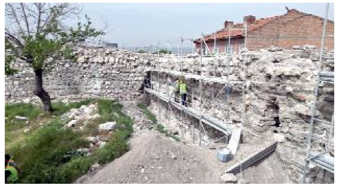
Şehrin önemli tarihi yapıları arasında yer alan Çorum Kalesi'nin restorasyon ihalesini kazanan yüklenici firma çalışmalarına devam ediyor.
