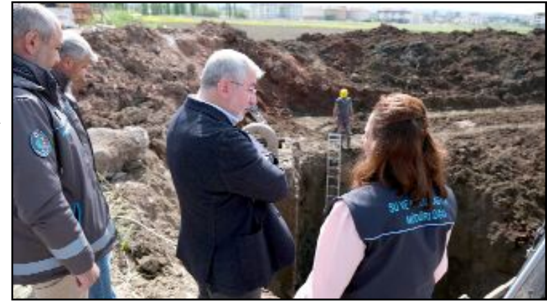
Ana isale hattındaki çalışmaları su kesintisi yapmadan gerçekleştiren ekipler onarımı başarılı bir şekilde gerçekleştirdi.
