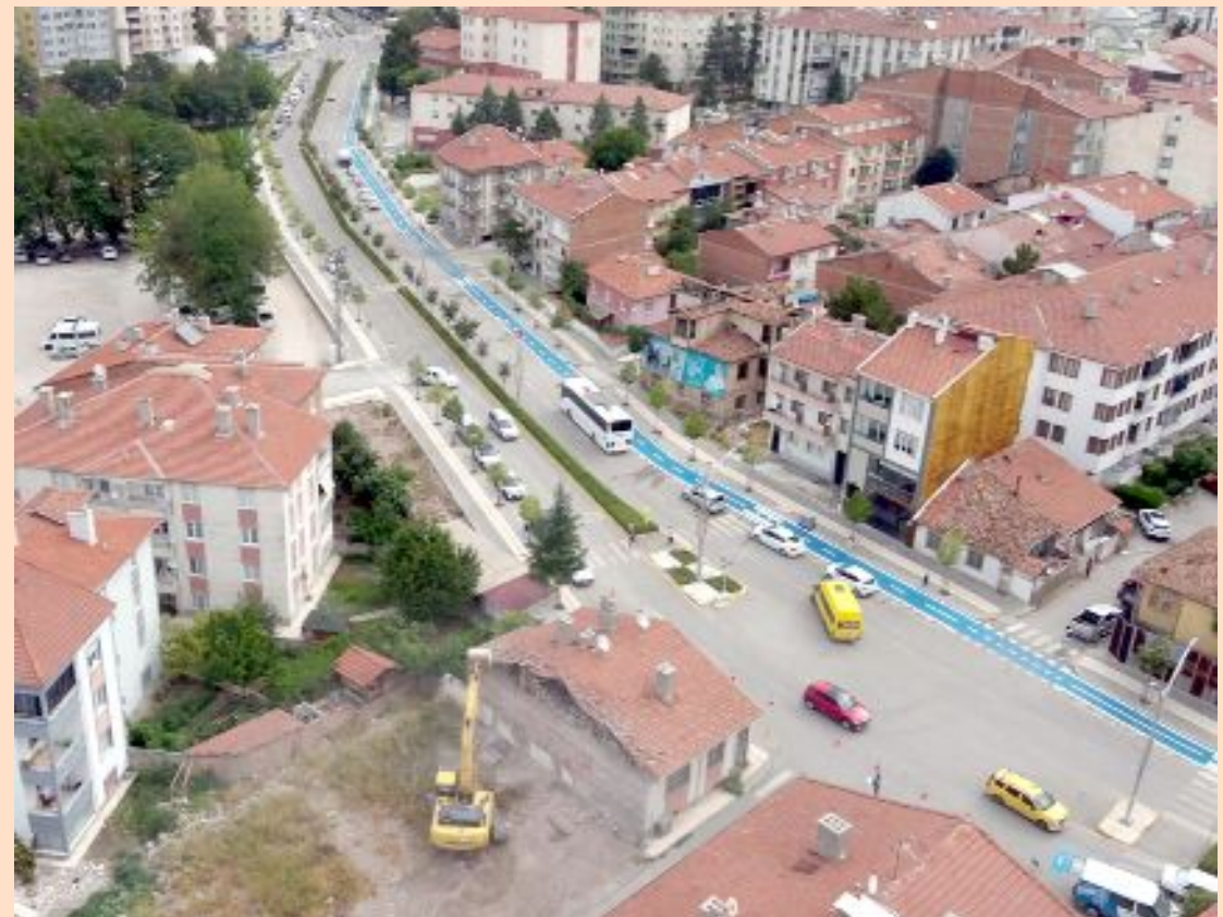
Çorum Belediyesi, Akşemseddin Caddesi ile Recep Tayyip Erdoğan Caddesi'ni birbirine bağlayacak 20 metre genişliğindeki bulvar için kamulaştırma ve yıkım çalışmalarına devam ediyor Recep Tayyip Erdoğan Caddesi ile Okul 1. Sokağın buluştuğu noktadaki birbinanın daha yıkım çalışmalarına başlandı.
