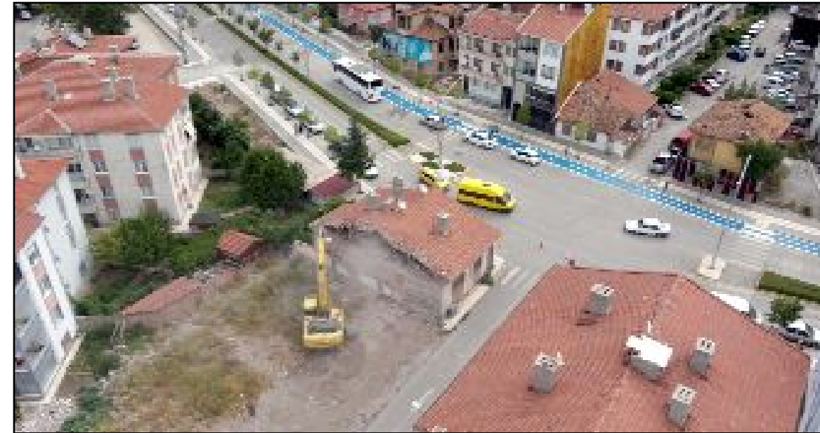
Binanın yıkımının tamamlanması ile trafik tıkanıklığının daha da azalacağı belirtildi.
