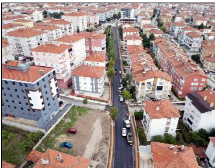
Fen İşleri Müdürlüğü'ne bağlı ekipler kaldırım çalışmasının ardından yolları yeni asfaltla kapladı.
