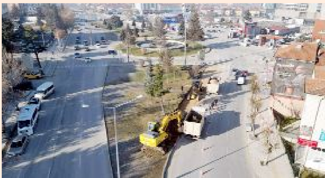
Abide Kavşağı'nda yapılan yeni düzenlemeyle yol 12 metreye çıkarılıyor.
