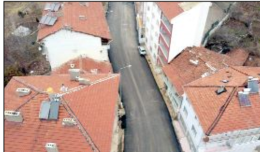
Bayat Belediyesi tarafından iki caddeyi birbirine bağlayan yol sıcak asfaltla buluşturuldu.
