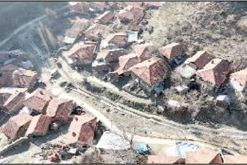
Beyoğlan köyüne 1415 metre betonarme taşkın kontrol duvarı, 5 menfez, 58 şut, 3 brit yapısı yapıldı.
