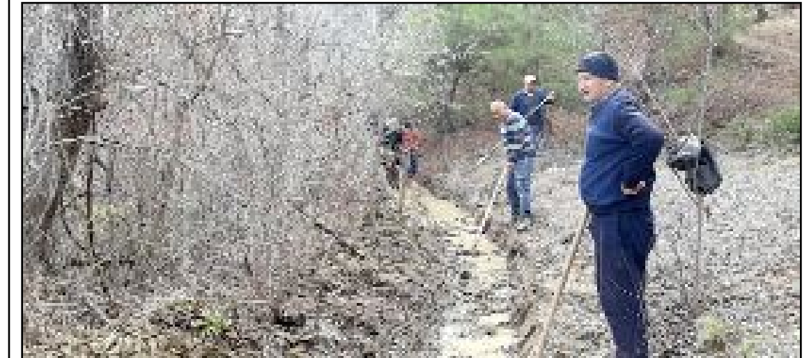
Aşdağul Belediyesi'nin hoparlörlerinden yapılan anonsla sabah saatlerinde su kanalına toplanan 20 çiftçi, kanalda temizlik çalışması yaptı.
