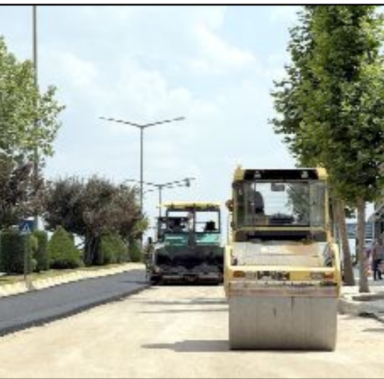
Belediye ekipleri 900 metre uzunluğa 13 metre genişliğe sahip caddeye toplamda 2 bin 200 ton asfalt serecek.
