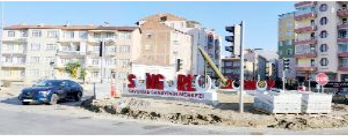
Sungurlu'nun Taşköprü Kavşağı'nda yapılan çalışmalardan bir görünüm.
