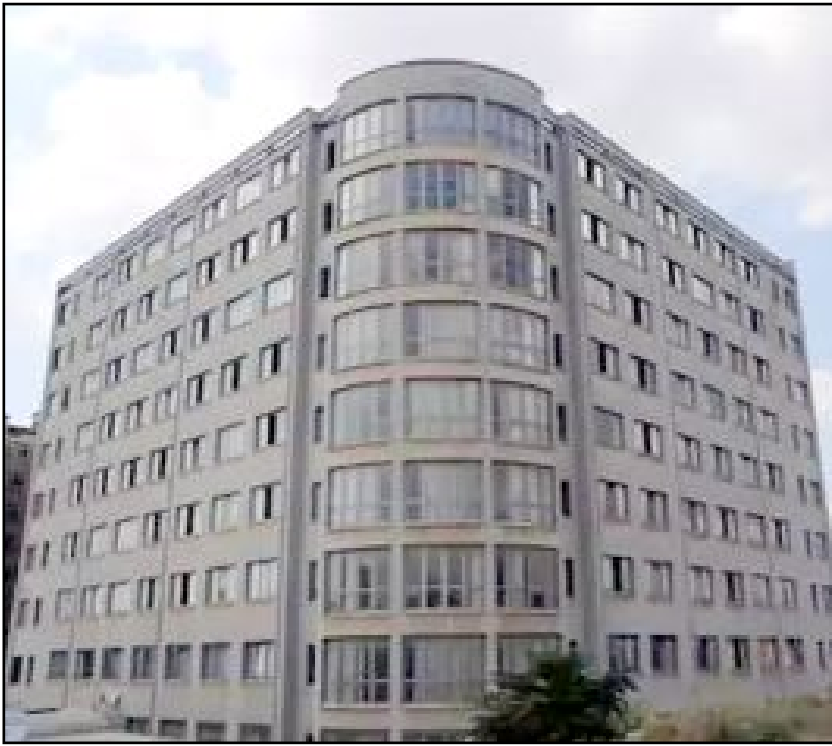
Eski Devlet Hastanesi'nin C bloğunun yıkımıyla ilgili ihalenin en kısa sürede yapılacağı bildirildi.
