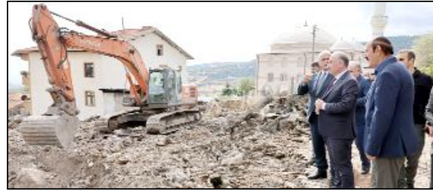
Vali Ali Çalgan, İskilip ilçesinde yangın nedeniyle 3 evin kullanılamaz hale geldiği Asarcık köyüne bağlı Kozveren mahallesini ziyaret etti.
