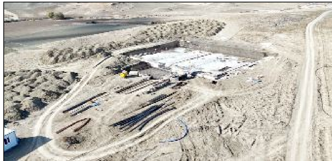
İlçede, 250 milyon TL'lik dev proje kapsamında 122 kilometrelik su hattı yenileniyor, 10 bin metrekupluk yeni depo inşa ediliyor.
