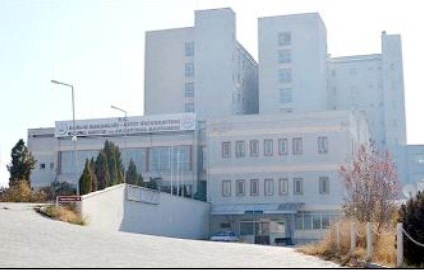
17 bin 852 metrekare kullanım alanına sahip 11 katlı bina yıkılacak.
