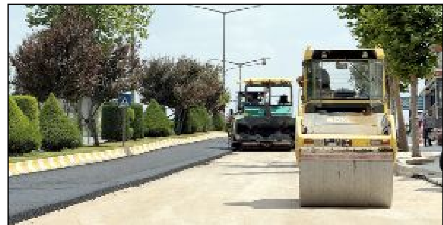
32 kilometre sathi kaplama ve 20 kilometre yeni yol açımı tamamlanırken, 45 kilometrelik kazı çalışması gerçekleştirildi.
