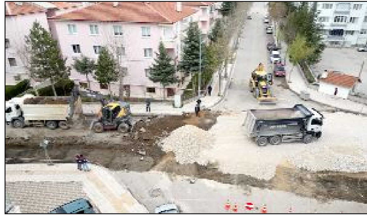
Çorum Belediyesi, 2025 yılı boyunca yürüttüğü altyapı ve üstyapı çalışmalarıyla şehri yeniledi.
