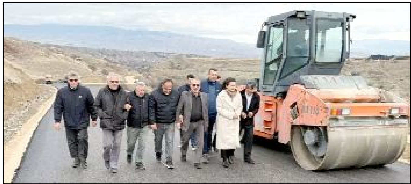
Dodurga Tutuş Köyü'ndeki grup yolunun asfaltlanması bölge halkını sevindirdi.
