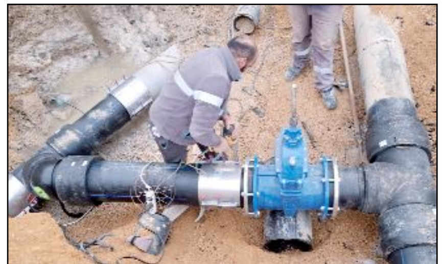
Pınarbaşı bölgesinde açılan yeni içme suyu kuyularından elde edilen suyun şehir şebekesine entegre edilmesi için yürütülen bağlantı çalışmalarının tamamlandığı açıklandı.
