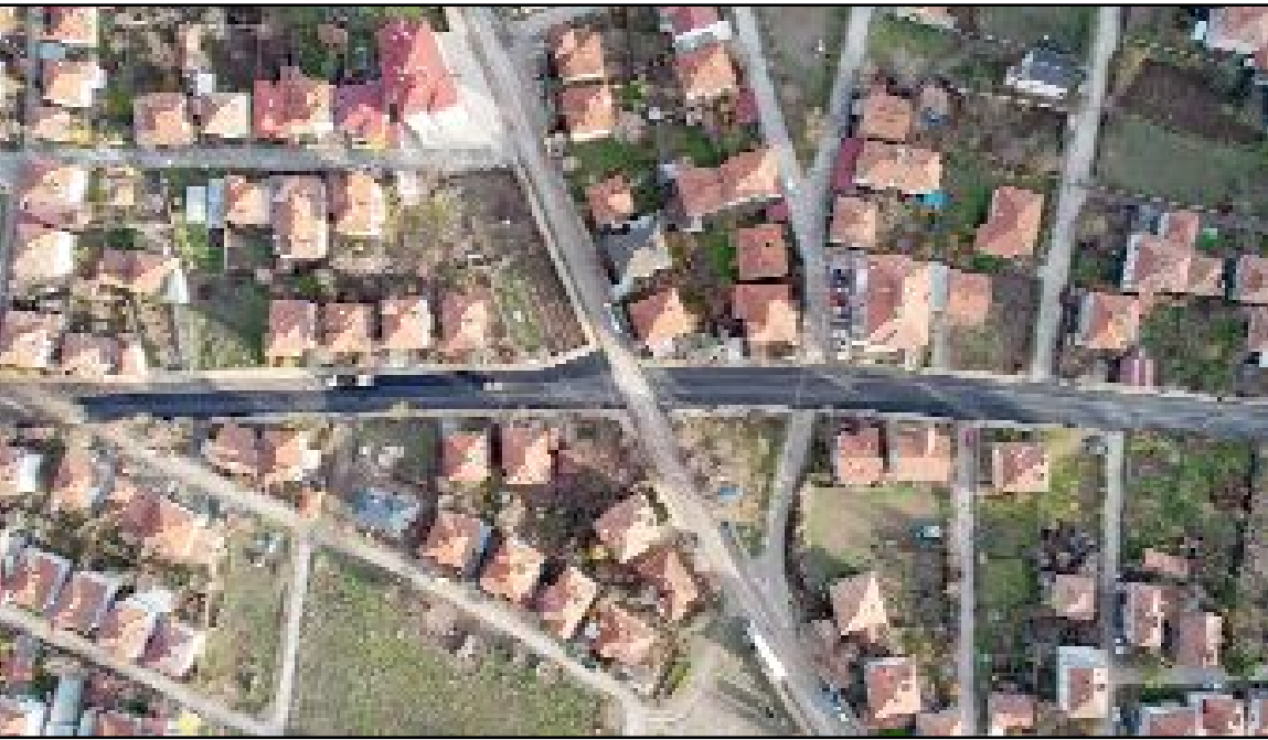
Belediye ekipleri Eymir, Gemici, Gürleyik, Şenyurt ve Koyunbaba mahallelerindeki cadde ve sokaklarda asfalt çalışmalarını tamamladı.
