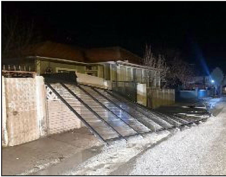
Çorum merkez ve ilçelerinde etkili olan kuvvetli rüzgâr nedeniyle bazı elektrik telleri koptu, ağaçlar devrildi.
