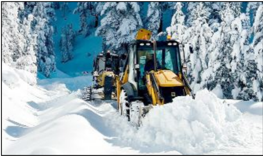
Ekipler, kapanan köy yollarında açma, temizleme ve genişletme çalışmalarını aralıksız sürdürüyor.
