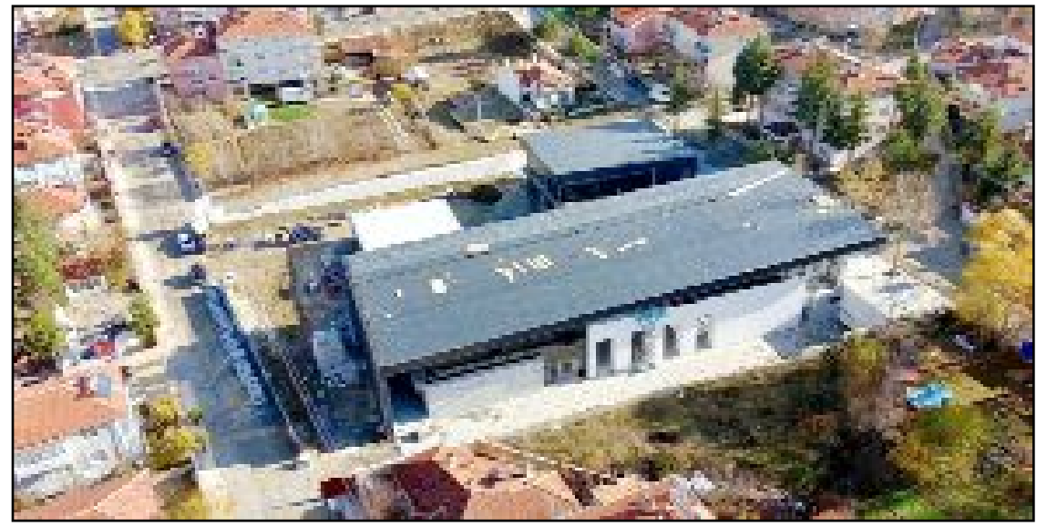
İBB'nin Mecitözü Belediyesi'ne desteğiyle, Bahçelievler Mahallesi Mehmet Ağar Parkı yanında bulunan yaklaşık 7 dönümlük alanda inşa edilen Kültür Merkezi tamamlandı.
