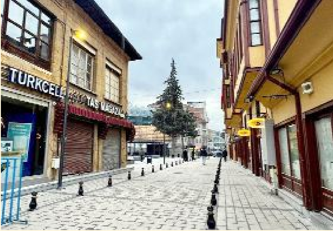
Velipaşa Hanı ile Taş Mağaza arasından, yeni açılan meydan ile Ayakkabıcılar Arastası'nı birleştiren yol...
