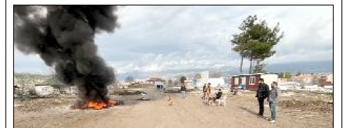
Aralarında kepçe operatörleri ve kalıp ustalarının da bulunduğu çalışanlar, dondurucu soğuk havaya rağmen şantiye alanında ateş yakarak eylemlerine devam ediyor.
