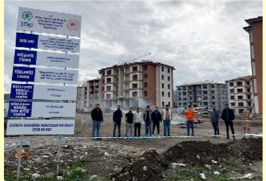
Gemici Mahallesi'nde yapımı süren 5. Etap 236 konut ve 4 dükkândan oluşan TOKİ inşaatında çalışan yaklaşık 50 işçi, ücretlerinin ödenmemesi nedeniyle çalışmayı durdurdu.
