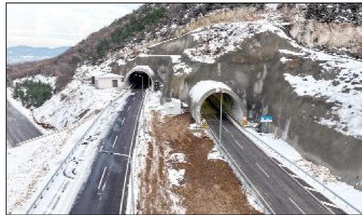
Bakan Uraloğlu, Kırkdilim'de inşa edilen ve toplam uzunluğu 4 bin 99 metre olan 3 çift tüp tünelde sona yaklaştıklarını açıkladı.
