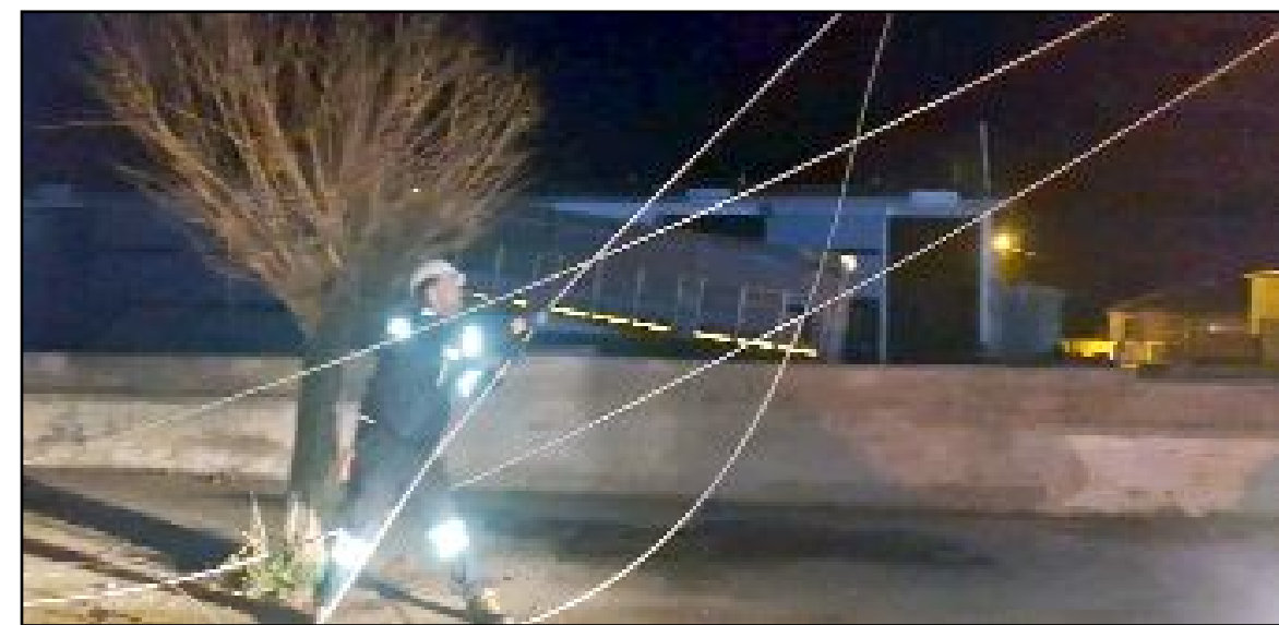
Ekipler, kopan kablolar ve kırılan direğin onarımı için çalışma başlattı.
