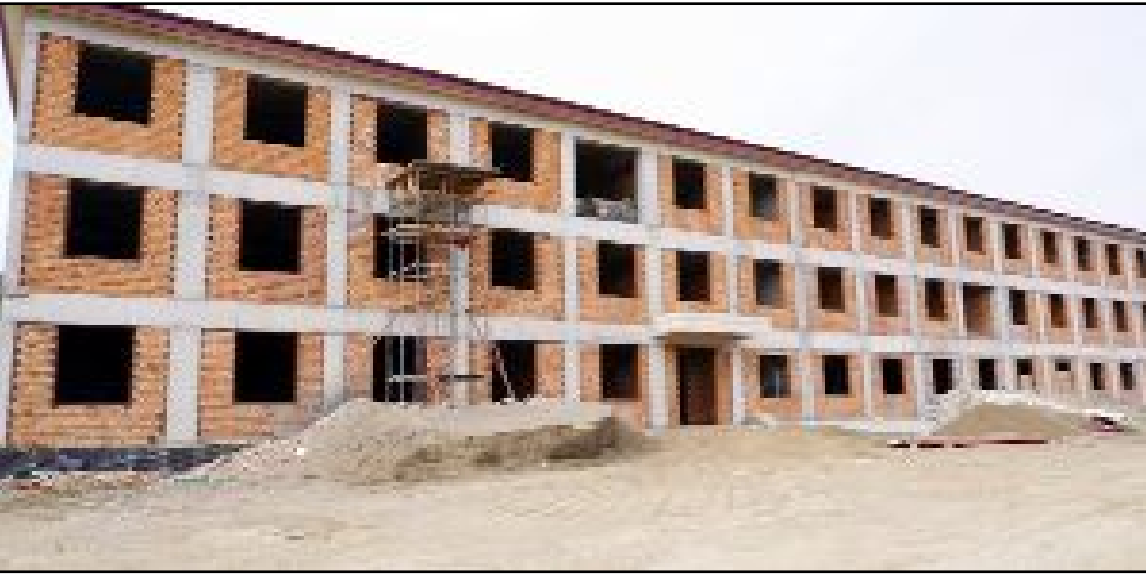
Kamil Yolu üzerinde yaklaşık 107.400 m2 arsa üzerine toplamda 43.550 m2 inşaat alanına sahip Osmancık Ceza İnfaz Kurumu ve eklentilerine ait inşaat çalışmaları devam ediyor.
