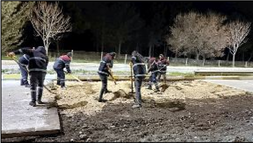
Şehir merkezinin önemli arterlerinden biri olan Gazi Caddesi'nde gece boyu yol bakım ve onarım çalışması gerçekleştirildi.
