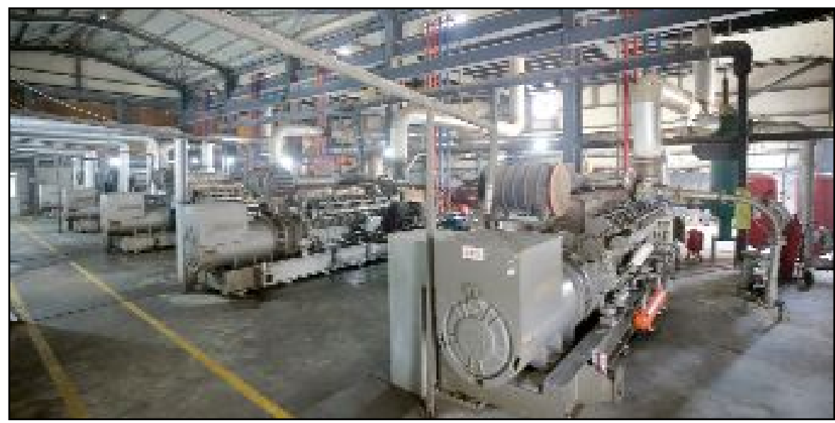
Çorum Biyogaz Tesisi'nde hayvan atıkları fermente edilerek 12 bin hanenin ihtiyacını karşılayacak elektrik enerjisi ve binlerce dekar arazide kullanılacak fermente gübre elde ediliyor.
