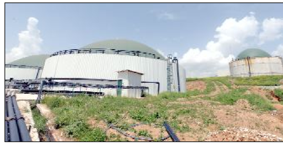
Çorum Biyogaz Tesisi'nde hayvan atıkları fermente edilerek 12 bin hanenin ihtiyacını karşılayacak elektrik enerjisi ve binlerce dekar arazide kullanılacak fermente gübre elde ediliyor.
