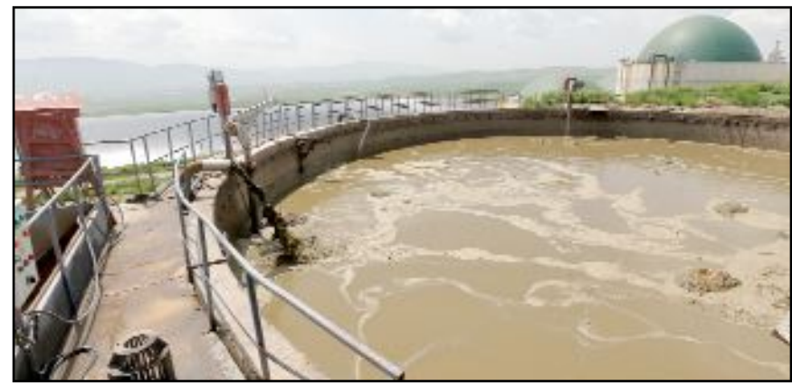
Tavuk çiftlikleri ile büyükbaş hayvan yetiştirilen mandıralardan toplanan atıklar, Çorum Biyogaz Enerji Tesisi'ne götürülerek dev havuzlarda beklemeye alınıyor.
