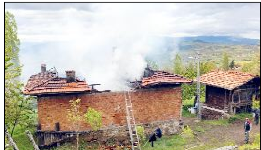
Oğuzlar Belediyesi itfaiye ekiplerince söndürülen yangında ev kullanılamaz hale geldi.
