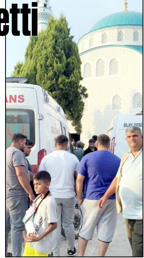
Olay, Aydın'ın İncirliova ilçesine bağlı Acarlar Mahallesi Adnan Menderes Bulvarı üzerindeki cami inşaatında meydana geldi.
