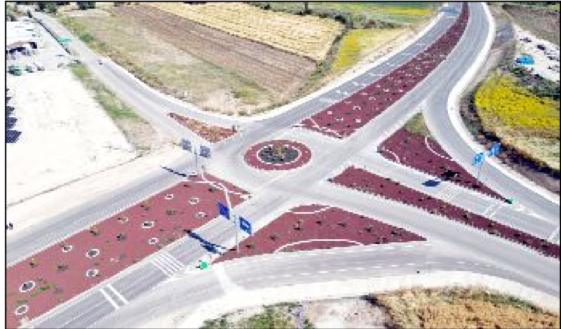
Karayolları Bölge Müdürlüğü tarafından yürütülecek çalışma kapsamında kavşağa sinyalizasyon sistemi kurulacak.
